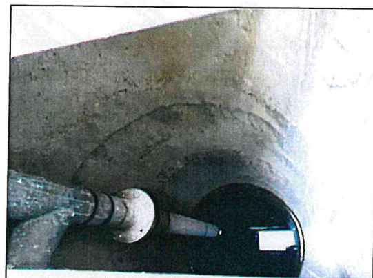
Intérieur du puits
